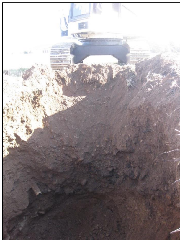
Foto 10. Materiale di riporto nella Trincea T8 – 0-4 metri.
