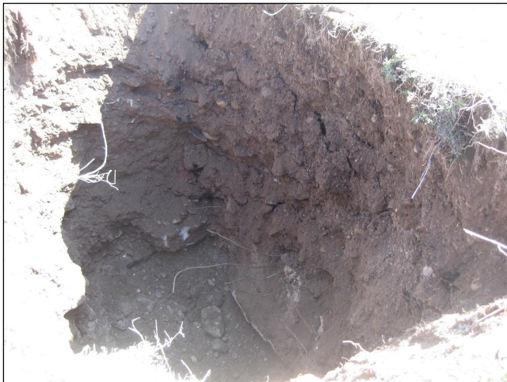
Foto 6. Materiale di riporto nella Trincea T5 – 0-3.7 metri.
