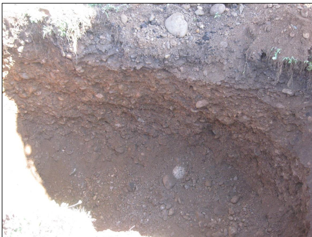
Foto 4. Materiale di riporto nella Trincea T4 - 0-0.5 metri.
