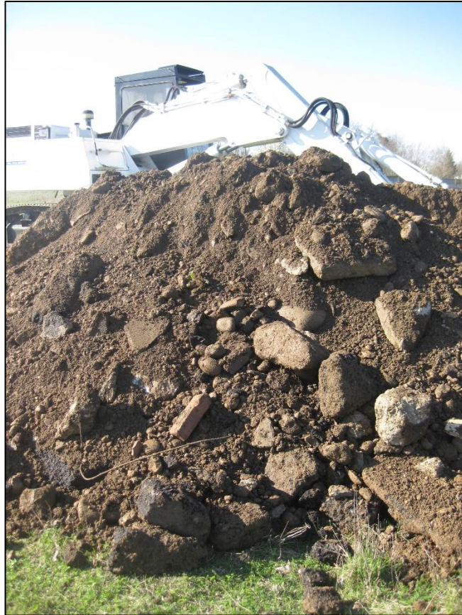
Foto 11. Materiale di riporto nella Trincea T9 – 0-3.2 metri.
