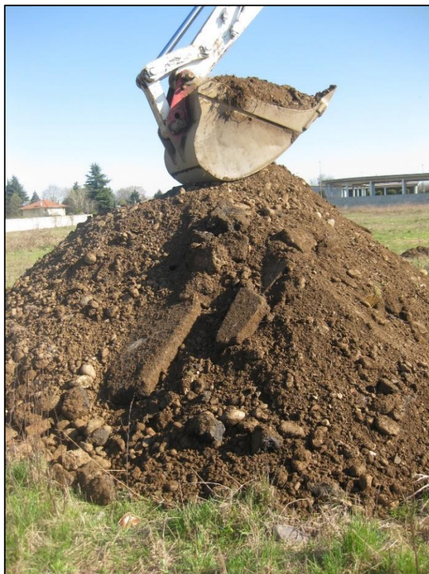
Foto 9. Materiale di riporto nella Trincea T8 – 0-4 metri.
