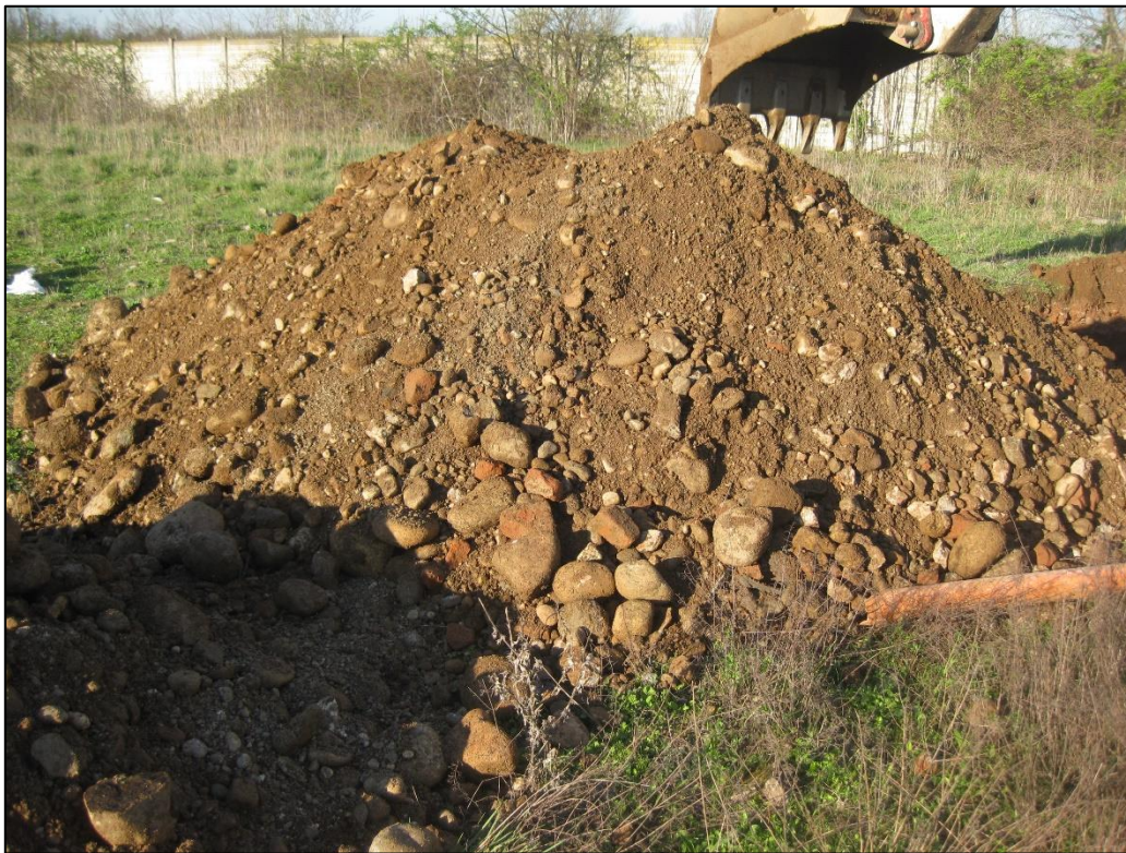
Foto 14. Materiale di riporto nella Trincea T10 – 0-3 metri con evidenza della soletta.
