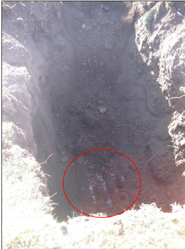
Foto 13. Materiale di riporto nella Trincea T9 – 0-3.2 metri con evidenza della soletta.
